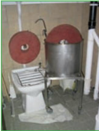
Nouvelle cuve métallique sur un support en hauteur avec roulettes
